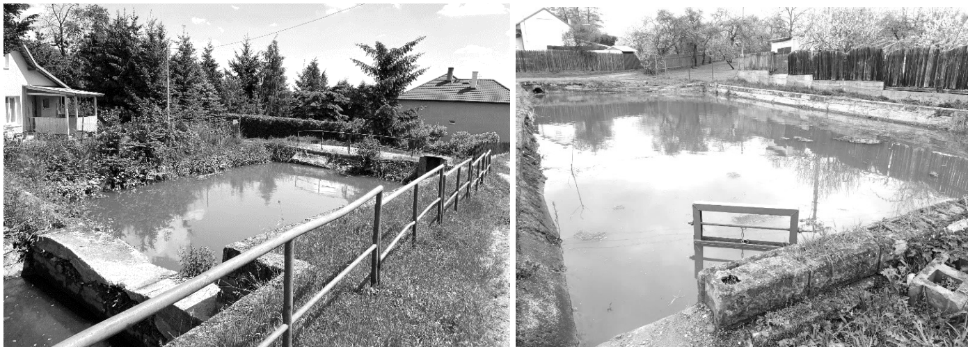
Horní i spodní požární nádrže naplněné vodou po vydatných deštích.
