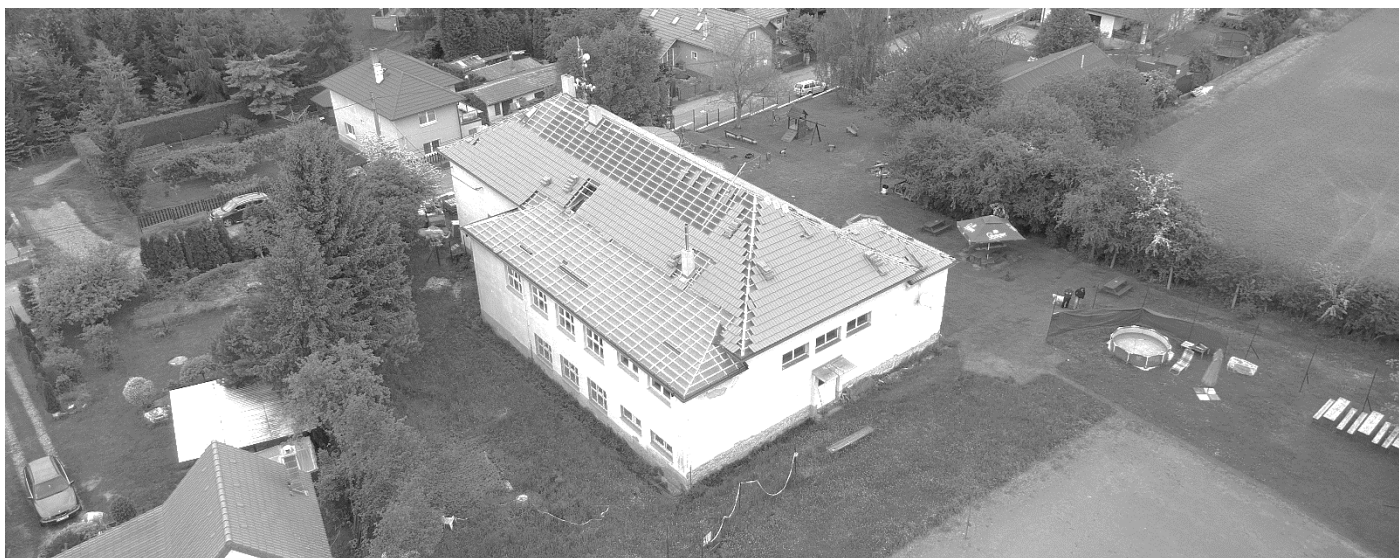
Oprava střechy budovy obecního úřadu.
