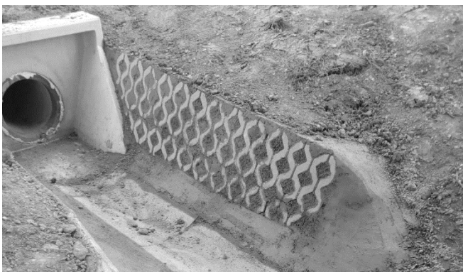
Oprava průtoku pod cestou
